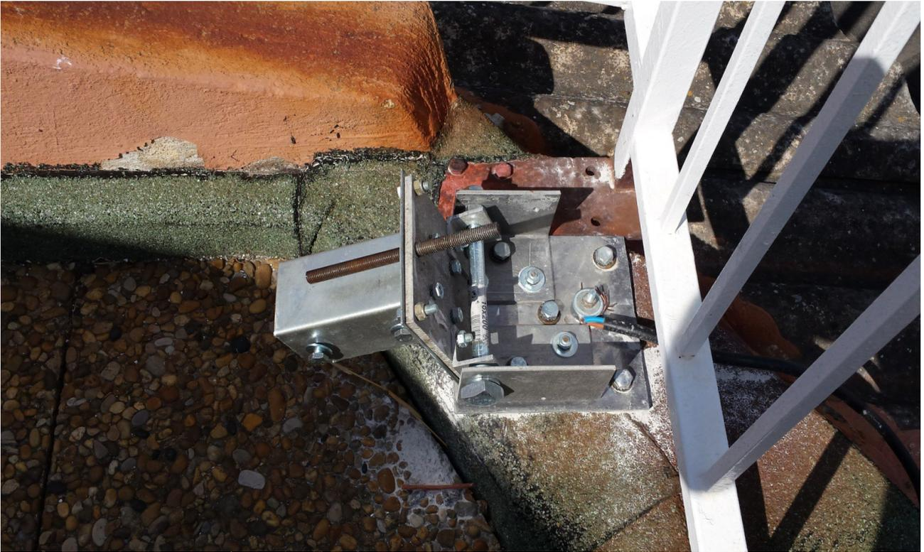
**Le support basculant du mât météo en position basculée**
