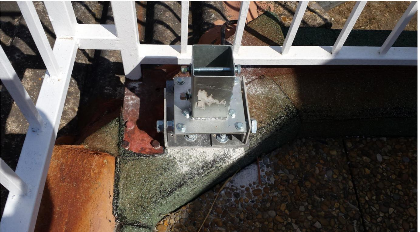
**Le support basculant du mât météo en position verticale**
